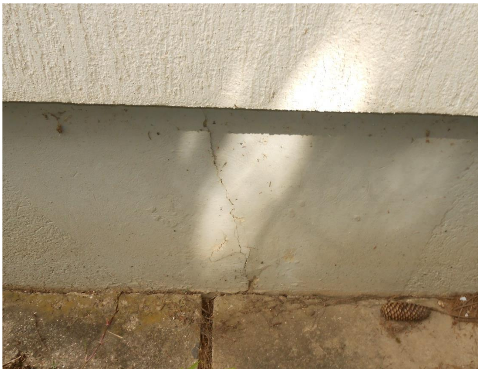
Slika števil. 4: primer razpoke zidnega nastavka vzdolžnega fasadnega zidu
